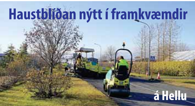
Það var falllegur dagur föstudaginn 16. október sl. á Suðurlandinu. Á Hellu var hann nýttur til að lagfæra malbiksskemmdir og endurnýja tvær hraðahindranir sem voru orðnar lúnar.
