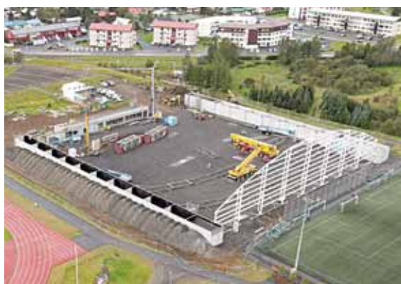
Fjölnota íþróttahús rís hratt þessa dagana en verið er að koma stálvirkinu fyrir á sínum stað.
