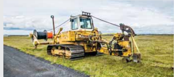
Jarðstrengur plægður meðfram vegi í Meðallandi.
