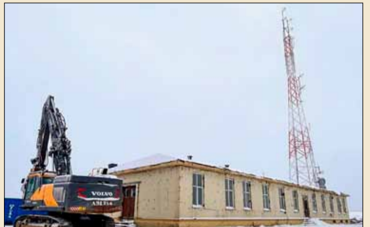
Vinnuvél komin á staðinn til að brjóta húsið niður.
