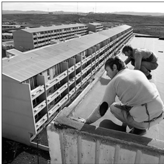
Hér má sjá unga menn við byggingavinnu á árdögum Breiðholtsins.
