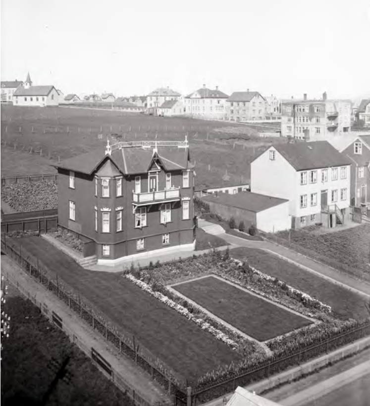
Húsið að Suðurgötu 12 byggt 1899 var fyrsta stóra „villan“ sem byggð var í Reykjavík. Garðurinn var í sama stíl, myndrænn og skrautlegur.
