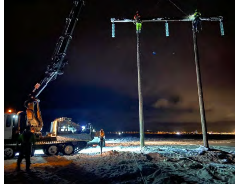
Íbúar í Dalvíkurbyggð fundu fyrir óveðrinu í fyrra m.a. með langvarandi rafmagnsleysi. Fyrrri hluta árs 2023 verður hafist handa við lagningu jarðstrengs frá Akureyri til Dalvíkur, rúmlega 40 kílómetra leið. Að verki loknu verður til staðar tvöföld tenging og afhendingaröryggi við Dalvík og svæðið utar á Tröllaskaga verður meira en það er nú.
