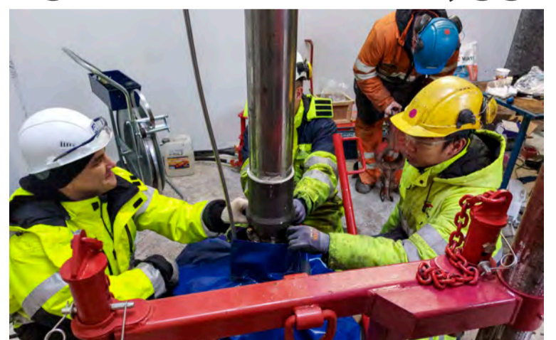
Unnið að endurbótum á heitavatnssvæðinu á Reykjum við Húnavelli.
