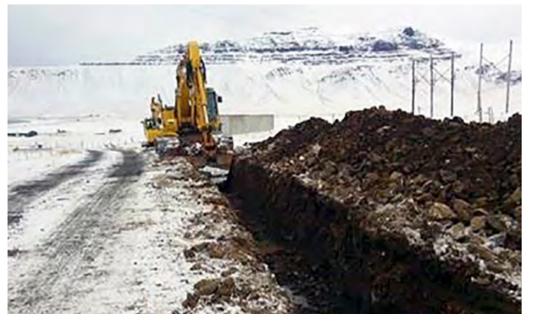
Framkvæmdir Landsnets á árinu hafa að hluta snúist um að koma raflínunum í jörð. Hér er unnið við að leggja jarðstreng við Grundarfjörð.
