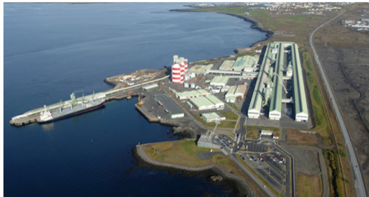
Álver Rio Tinto í Staumsvík var upphaflega í eigu svissneska félagsins Aluisse. Verksmiðjan var formlega vígð í maí 1970 með framleiðslugetu í 120 kerum upp á 33.000 tonn á ári. Nú er framleiðslugetan um 211.000 tonn.
