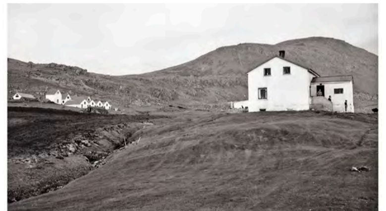
Fundarstaður stofnfundar félagsins 1931. Íbúðarhúsið í Kollsvík var byggt 1924 samkvæmt fasteignamati. Eigandi myndar / Ljósmyndasafn Vestur-Barðastrandarsýslu.
