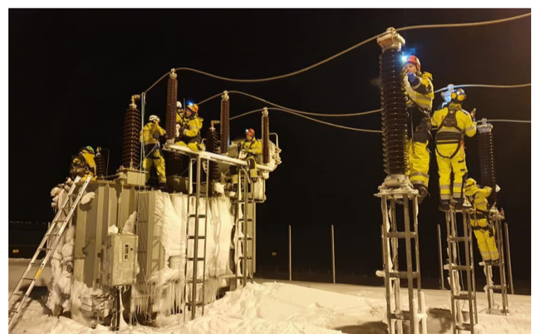
Framkvæmdum við yfirbyggingu tengivirkis við Hrutátungu í Hrutafirði var ein af þeim sem sett var framur í forgangsroðun í kjölfarið á óveðrinu í fyrra.
