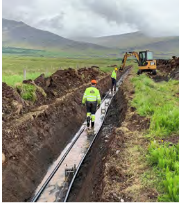
Unnið að lagningu á Akraneslínu í jörðu.
