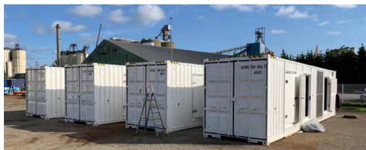
Landsnet hefur keypt fimm færarlegar varaafstöðvar, samtals 6 MW og nemur kostnaður um 450 milljónum króna. Fyrirtækið hefur hug á að kaupa fimm til viðbótar til að tryggja það að eigi aldrei á að líða langur tími án rafmagns hvar sem er á landinu.
