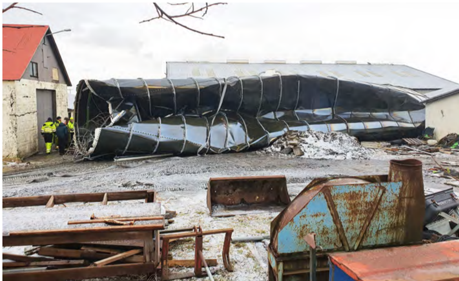
Súrheysturninn á bænum Skiðbakka II í Austur-Landeyjum beygladist saman í rokinu og var í kjölfarið togaður niður. Turninn, sem var 21 metri á hæð og 18 tonn að þyngd, hefur verið á Skiðbakka í rúmlega 30 ár. Hann var notaður undir korn og sem fjarskiptamastur hin síðari ár.
