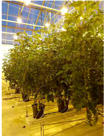
Mynd 1: HPS lampar með rafeindastraumfestu fyrir ofan tómataplöntur.
