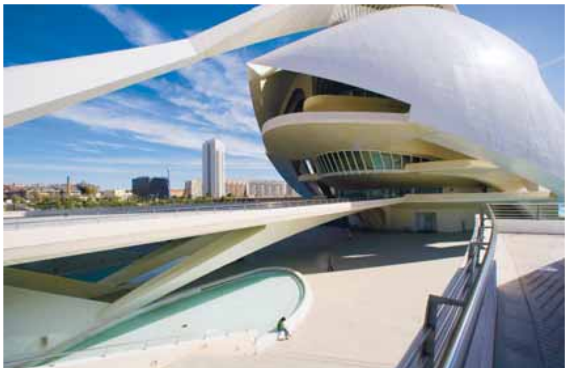
Valencia Bakhlið óperuhúss Sofíu drottningar í Valencia..
