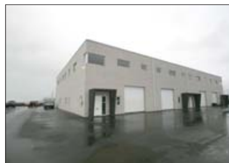
Gjáhella - Atvh. - Hagstætt verð. Nýkomin nokkur bíl í þessu vandaða atvinnuhúsnæði. Um er að ræða 120 fm. grunnflötur auk 120 fm. steypt milliloft, samtals 240 fm. Mikil lofthæð og innkeyrsludyr. malbikuð lóð. Verð 14,9 millj.
