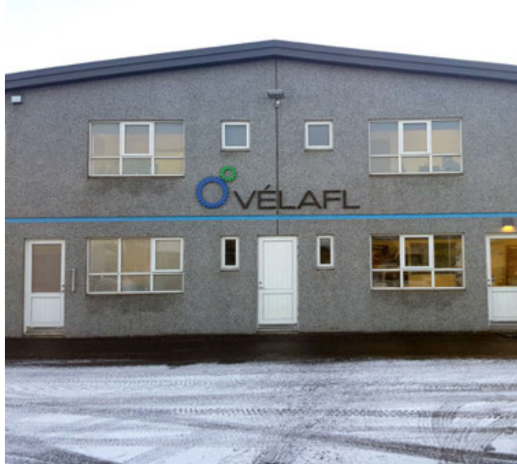
Vélafl er til húsa í nýlegu og rúmgóðu húsnæði að Rauðhelli 11 í Hafnarfirði sem inniheldur m.a. 1.380 m 2 verkstæði og lager.
