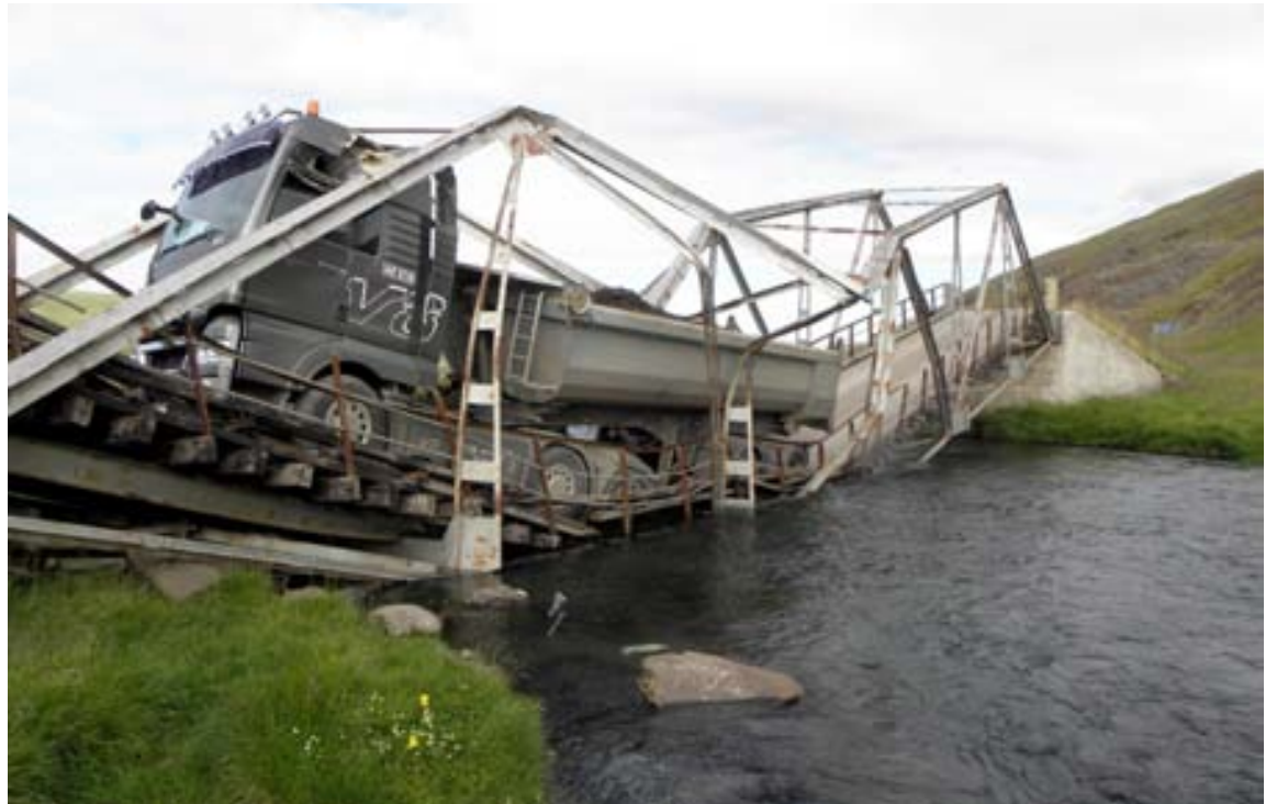
Brúin yfir Vatnsdalsá hrundi þann 18. ágúst síðastliðinn. Brúin er gerónýtt og bráðabirgðabréu hefur verið reist fimmtíu metrum frá gamla brúarstæðinu.
