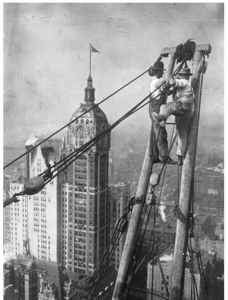
Byggingarverkamenn að störfum hátt yfir húspökum New York-borgar árið 1925. Singer-byggingin sést í bakgrunni. NORDICPHOTOS/GETTY
