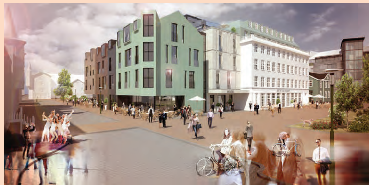
Framkvæmdum við nýtt hótél við Austurvöll átti að ljúka vorið 2018.
