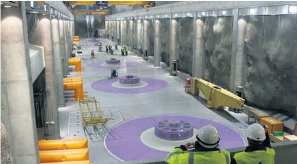
KÁRAHNJÚKAVIRKJUN Dýrasta framkvæmd Landsvirkjunar er jafnframt sú framkvæmd sem hefur verið dýrust miðað við framleiðslugetu.
