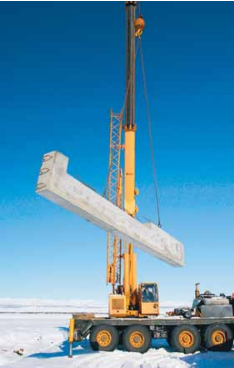
Byggingarframkvæmdir á nýju nautastöðinni hafa gengið vel að sögn Gunnars og er áætlað að þeim ljúki í júlí og stöðin verði tekin í notkun í haust. MYND/ÁSKELL ÞÓRISSON
