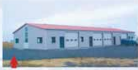
Iðnaðarhúsnæði í byggingu á Hvoilsvelli
