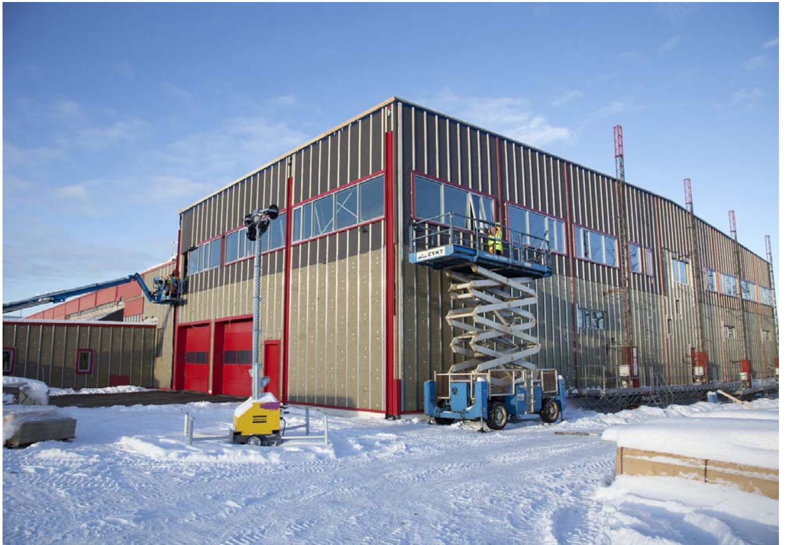
Áætlað er að viðbygging við flutningamiðstöð Póstsins kosti 698 milljónir en upphaflega var stefnt að allt að 2,2 milljarða framkvæmd. FRÉTTABLAÐIÐ/STEFÁN
