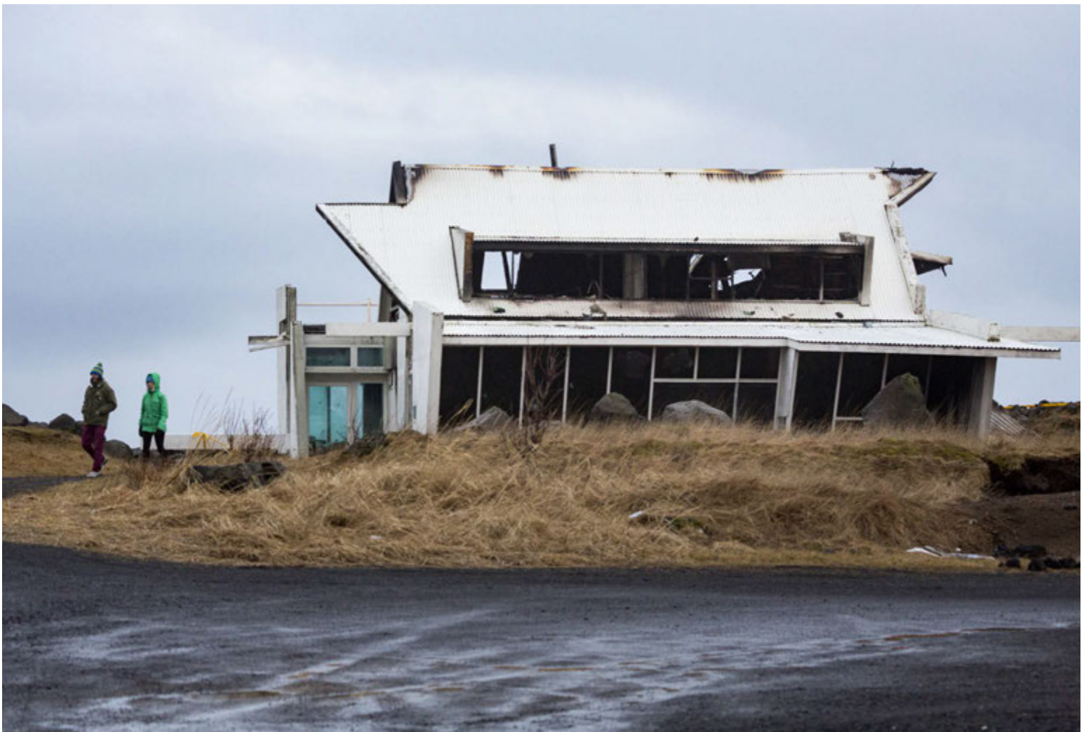
Ekki hefur verið tekin ákvörðun um hvað verður um húsið Eymd á Stokkseyri sem varð alelda á sunnudaginn. Bárður Guðmundsson, byggingafulltrúi í Árborg, gerir ráð fyrir að í dag verði net strengt yfir húsið til að varna því að lausar þakplötur og annað fjúki. FRÉTTABLAÐIÐ/EYFÖR
