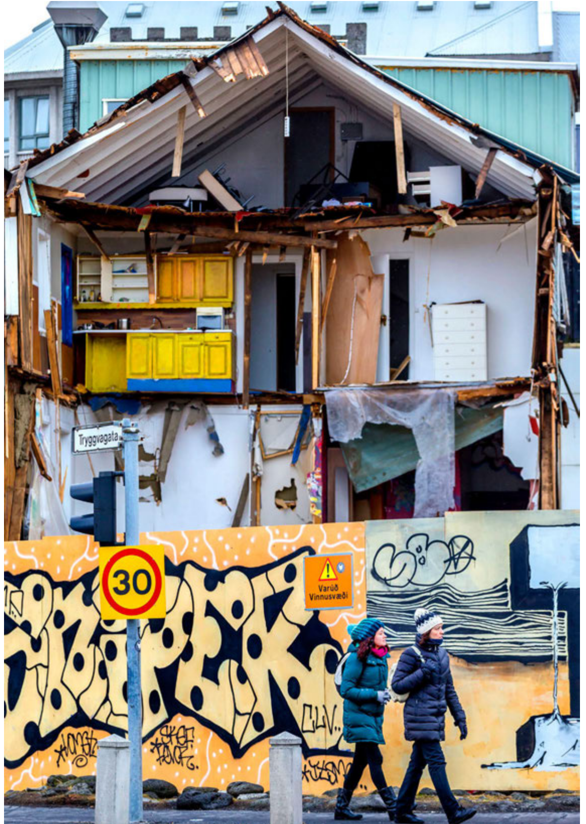
Rífið niður Framkvæmdir standa nú yfir á Naustareit við Tryggvagötu þar sem til stendur að byggja 110 herbergja hótél. Óánægja hefur verið meðal íbúa í nágrenninu sem kæra sig ekki um fleiri hótél í hverfið. FRÉTTABLAÐIÐ/VILHELM
