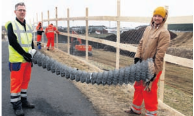
ÖRYGGIÐ Í FYRIRRÚMI Byrjað er að girða af framkvæmdavæðið við Hlíðarendu í Reykjavík. Til verksins er sagt þurfa um 1.200 metra af girðingarefni. FRÉTTABLAÐIÐ/GVA
