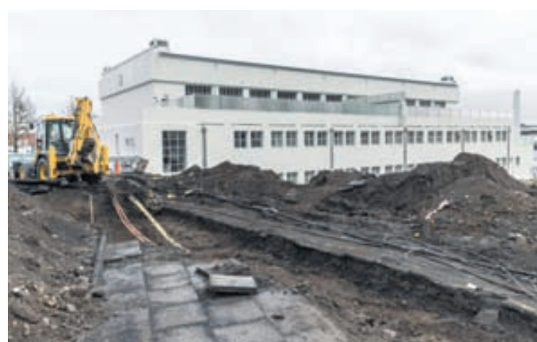
RAFLAGNIR FÆRÐAR Orkuveitan vinnur nú að tilflutningi raflagna áður en raunverulegur uppgröftur vegna laugarsvæðisins hefst. FRÉTTABLAÐIÐ/VILHELM
