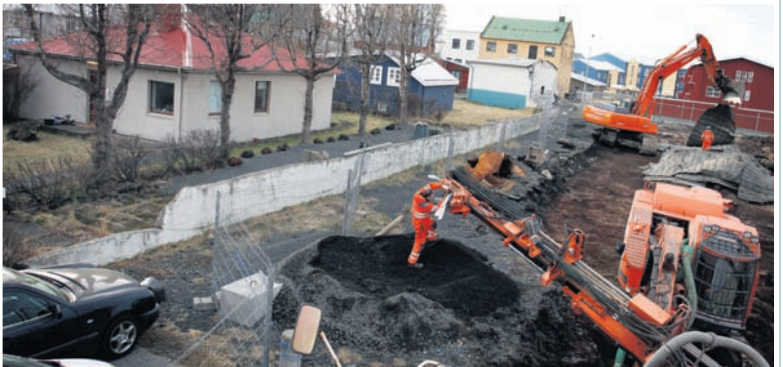
SPRENGT Í BAKGARÐINUM „Hér hefur allt nötrað og skolfið fimm til sex sinnum á dag frá því að byrjað var að sprengja,“ segir Svanlaug Rós Ásgeirsdóttir sem býr aðeins sex metra frá þeim stað þar sem sprengt er fyrir bílakjallara fjölbýlishúss á Lýsisreitnum. Íbúar vilja bætur vegna skemmda en verktakinn segist hafa sprengt innan viðmiðunarmarka. Sjá síðu 4.
