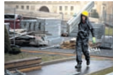
INNFLYTJANDI Í SVISS Spænskur byggingaverkamadur vinnur að framkvæmdum hjá höfuðstöðvum Sameinuðu þjóðanna í Genf. FRÉTTABLAÐIÐ/AF
