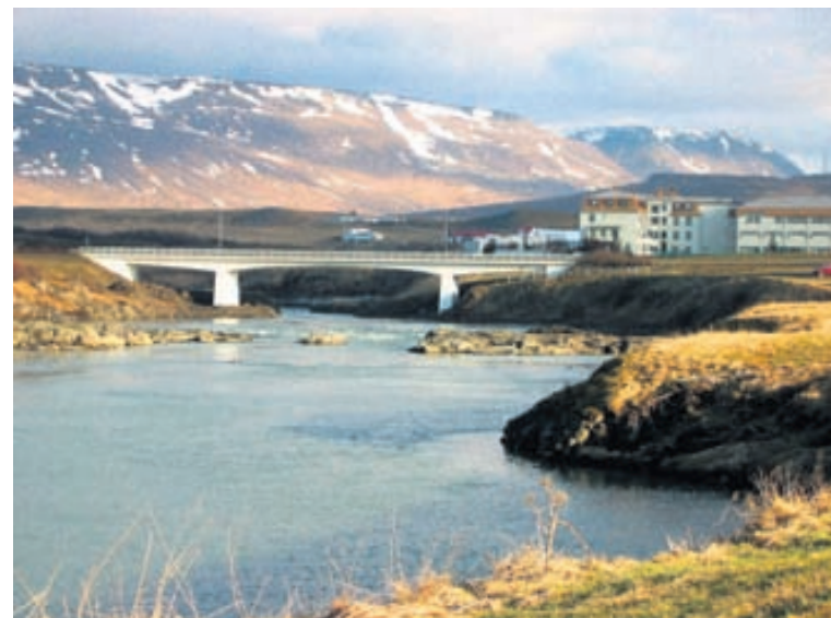
BLÖNDUÓSRÚ Brúin yfir Blöndu er orðin 50 ára gömul – byggð á árunum 1962 til 1963.
