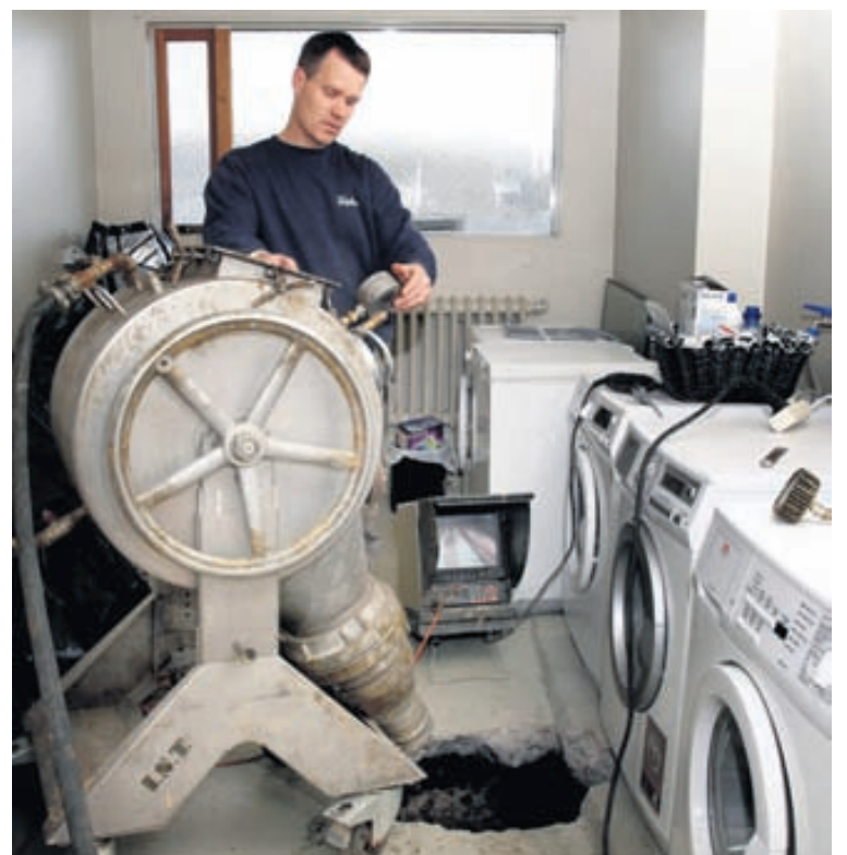
GG Lagnir sjá um almenna pípulagningaþjónustu hvort sem um er að ræða nýlagnir, viðhald, viðgerðir, snjóbræðslulagnir eða að skipta um dren og skólplagnir í eldra húsnæði.
