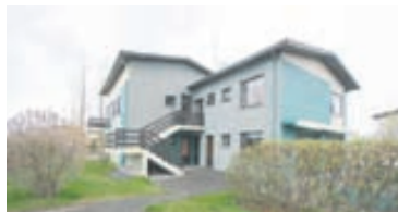
Nýkomin sér. falleg nýstandsett efri sérhæð m. innbyggðum bílskúr samtals 162 fm. Allar innréttingar og gólfefni hafa verið endurnýjað á vandaðan máta. Risloft yfir íbúð sem möguleiki er að innrétta. Hús góðu standi. Verð 39,2 millj.
