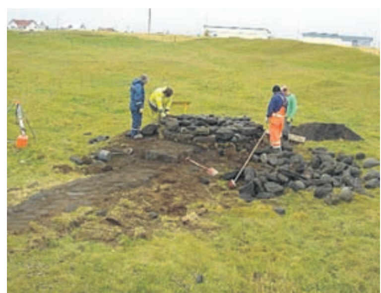
VATNSBÓLIÐ Stígur er lagður að gamla brunnum og varnargrind komið þar fyrir.
