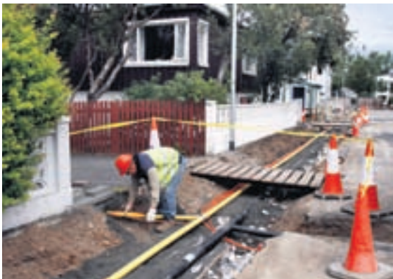
RASK Reykjavíkurborg ákvað að endurnýja gangstéttir við nokkrar götur í Skerjafirðinum í sumar, og nota veitufyrirtæki tækifærið til að koma lögnum í jörð.
