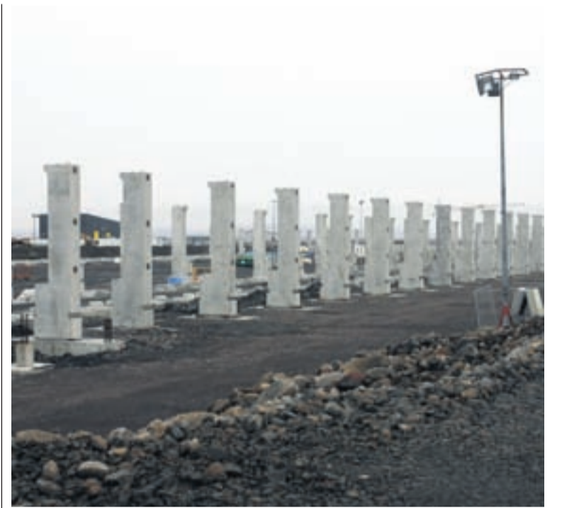
HELGVÍK Framkvæmdir við álverið eru komnar á veg en ekki var mikið um að vera á framkvæmdasvæðinu þegar ljósmyndari átti leið hjá síðdegis í gær. MYND/VÍKURFRÉTTIR
