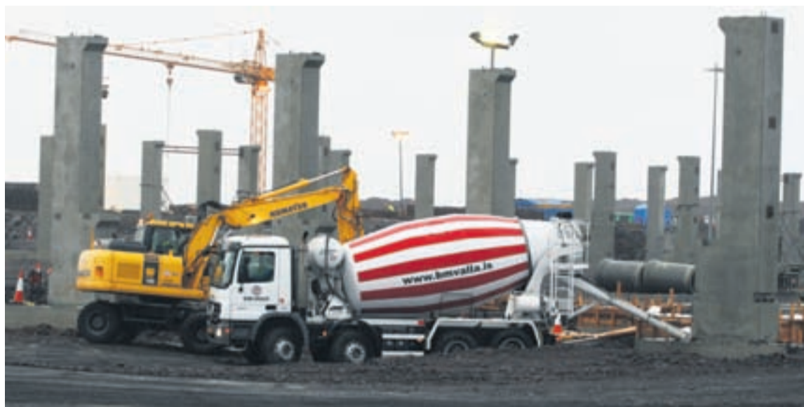
VIÐ UPPSTEYPU Í HELGUVÍK Atvinnuleysi í landinu er einna mest á Suðurnesjum. Á Suðurnesjum eru tæplega 1.800 einstaklingar atvinnulausir en verulega hefur hægt á framkvæmdum Norðurlás í Helguvík. Þar má þó enn sjá steypubíla og menn að störfum við uppsteypu. FRÉTTABLAÐIÐ/GVA
