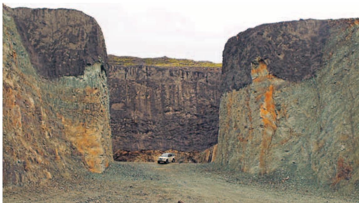
FRÁ BÚÐARHÁLSI Sprengt var fyrir stöðvarhúsi Búðarhálsvirkjunar áður en framkvæmdum var frestað árið 2003.
