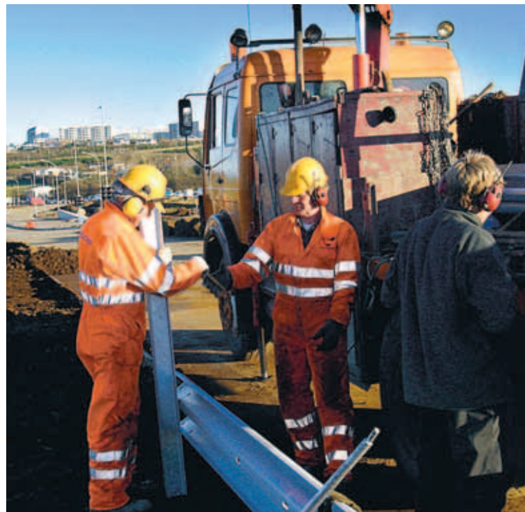
UNNIÐ VIÐ REYKJANESBRAUT Ístak hyggst segja um 300 manns upp störfum á næstunni. Félagið hefur unnið við Hraunaveitu, Reykjanesbraut og fleiri verk. Sumum þeirra er að ljúka og óvíst hvað tekur við. MYND/E.ÓL.
