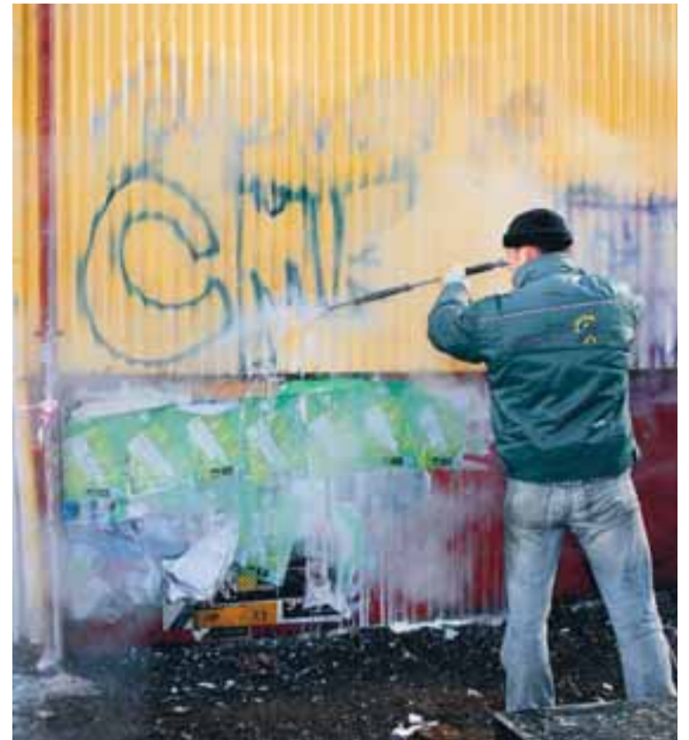
VEGGJAKROT Í REYKJAVÍK Starfsmenn Reykjavíkurborgar hófu í gær að hreinsa veggjakrot af húsum við Laugaveg.
