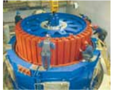
STÖÐVARHÚSIÐ Rafalar Kárahnjúkavirkjunar fara brátt að snúast fyrir vatnsafl.
