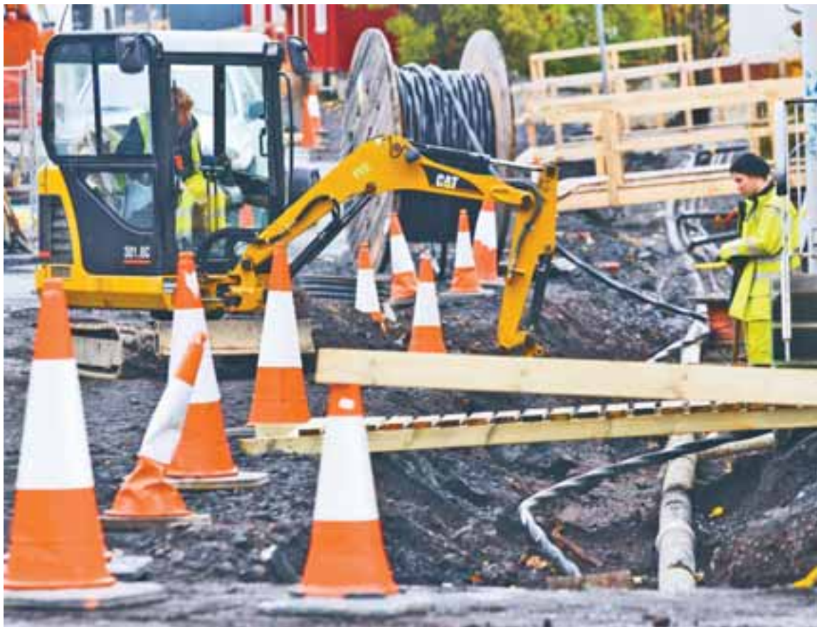
FRAMKVÆMDIR Verktakar hafa haft í nógu að snúast undanfarið og sveitarfélög á höfuðborgarsvæðinu hafa sum hver þurft að fresta útboðum þar sem tilboð hafa ekki borist, eða verið langt yfir kostnaðaráætlun.
