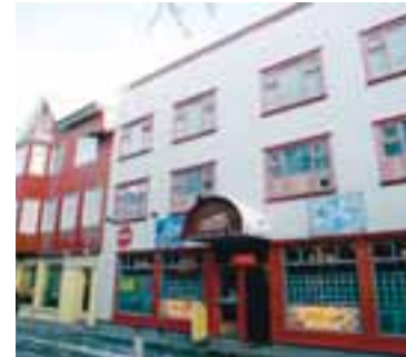
LAUGAVEGUR 19 Byggt 1904 og verður rífið.
