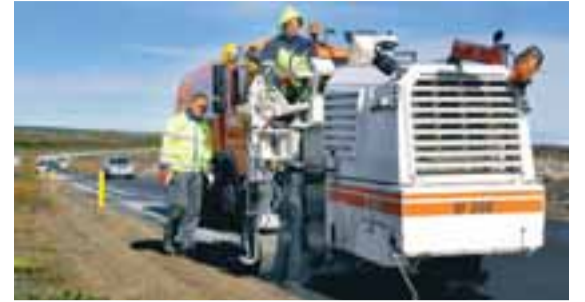
FRÆST Á GRINDAVÍKURVEGI Þegar ekið er yfir rifflurnar skapast titringur sem varar ökumanninn við hættu. FRÉTTABLAÐIÐ/GVA
