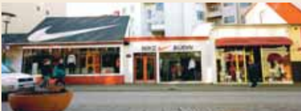
LAUGAVEGUR 4-6 Formaður skipulagsráðs Reykjavíkurborgar segir að vinna við húsverndaráætlun taki langan tíma og það sé óraunhæft að setja allar framkvæmdir í miðborginni í biðstöðu á meðan. FRÉTTABLAÐIÐ/TEITUR
