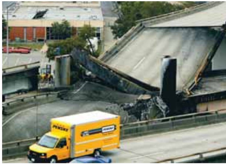
BRÚIN HRUNIN Brúin sem hrundi var hluti af aðreinn inn á brú yfir Oakland Bay.
