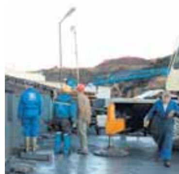
BRUNARÚSTIR FISKIMJÖLSVERKSMÍÐJUNNAR Starfsmenn Fiskimjölsværksmiðju Ísfélags Vestmannaeyja og smiðir fyrirtækisins Steina og Olla horfa yfir brunarústir fiskimjölsværksmiðjunnar meðan Guðjón Engilbertsson verksmiðjustjóri stjórnar krananum. Þeir hafa undanfarna daga unnið að hreinsun svæðisins en kveikt var í verksmiðjunni 16. desember. MYND/ÓSKAR P. FRÍÐRIKSSON
