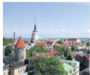
Tallinn er best varðveitta miðaldaborg Norður-Evrópu en er þó samtímis nútímaleg borg með alþjóðlegu yfirbragði.
