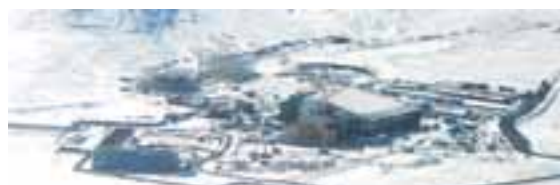
HELLISHEIÐARVIRKJUN Framkvæmdum við stækkun Helligheiðarvirkjunar hefur verið frestað.
