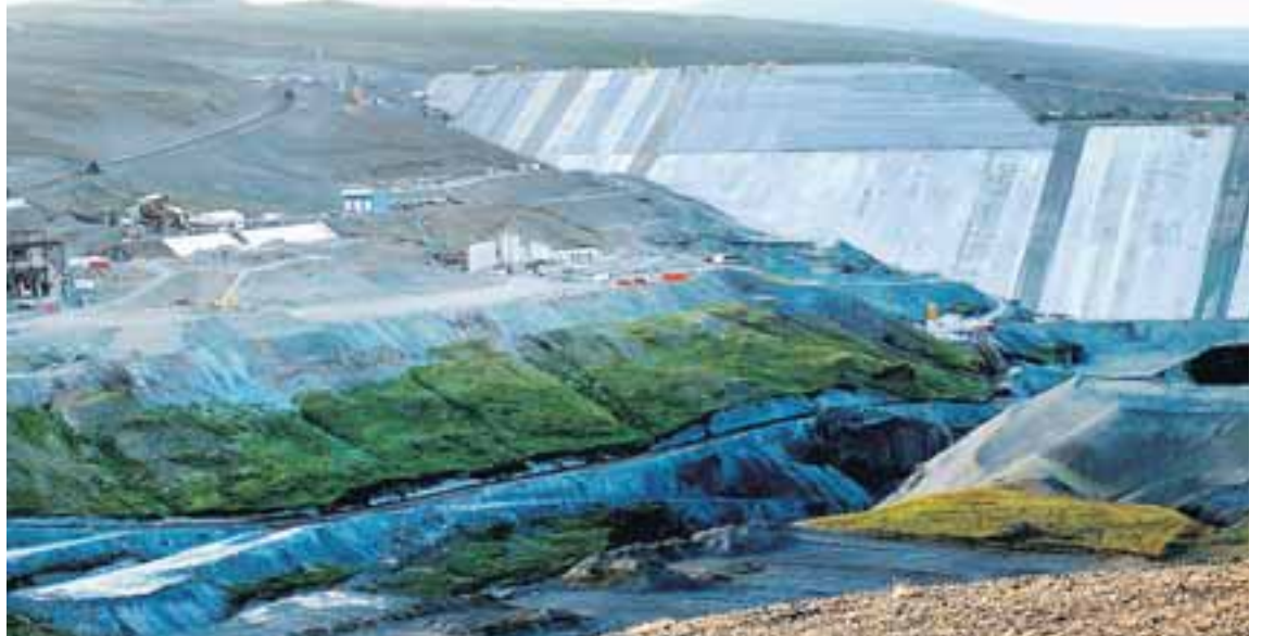
FRÁ FRAMKVÆMDASVÆÐINU VIÐ KÁRAHNJÚKA Nýjstu rannsóknir á framkvæmdasvæðinu við Kárahnjúka sýna ótvírætt að Kárahnjúkavirkjun er reist á sprungusvæði. Niðurstöðurnar eru þó ekki taldar hafa áhrif á framgang Kárahnjúkaverkefnisins. FRÉTTABLAÐIÐ/GVA
