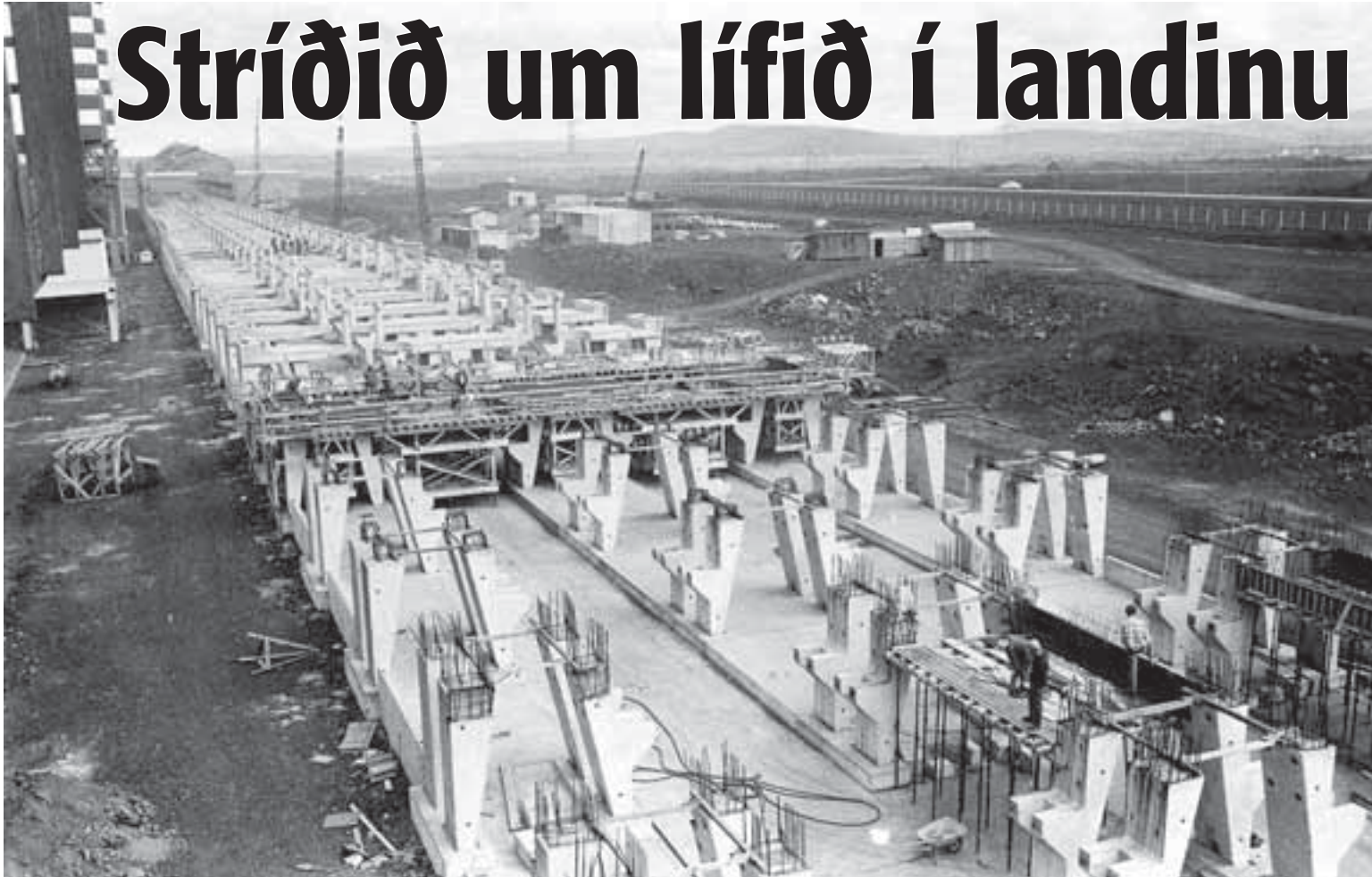
STRAUMSVÍK Kerskáli 1 í byggingu. Þegar ráðist var í byggingu álversins þekktu Íslendingar ekki til bygginga af þeirri stærðargráðu sem kerskálarnir eru. Þetta var eitt af því sem stakk fólk í augu og olli töluverðri gagnrýni. Sjónmengun var þó ekki eins mikið í deiglu og þau áhrif sem Búrfellsvirkjun var talin hafa á umhverfið.
