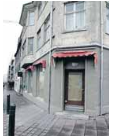
LAUGAVEGUR 82 Lífstykkjabúðin er að flytja frá Laugavegi 4 og hingað í þetta glæsilega hornhús. Til stendur að rífa húsnæðið sem hýsir verslunina núna en nýja húsnæðið er meira en tvöfalt stærra en það gamla.
