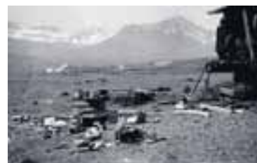
Ekki var alltaf hlaupið að því að fara með vélar á verkstæði. Hér er búið að slátra gröfu á hentugu plani rétt hjá vinnusvæði. Ekki var óalgengt að skipta þyrftu um mótora í gröfunum úti á túni. Því þurftu allir sem unnu við gröft að kunna skil á vélum og viðgerðum. LIÓSMYND: PÁLL SIGURGEIRSSON
