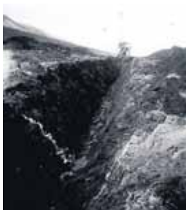
Ræktunarskurðirnir voru um 2,5 metrar að dýpt. Unnið var allan sólarhringinn á vöktum. Tveir voru á hverri vakt, annar að grafa og hinn að stinga fyrir bökkunum, sem var skilyrði. Seinna smíðaði Páll í félagi við aðra hnif sem var settur í beisli á traktor til sama verks og sparaði þannig heilan mann. LIÓSMYND: PÁLL SIGURGEIRSSON
