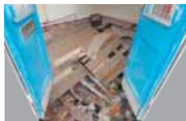
GÓLFÍÐ ER GJÖRÓNÝTT Húsið var notað sem moska.
