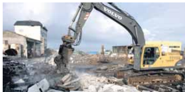
HAMAST Á STEYPU OG VÍRUM Síðustu vikur hefur verið unnið af kappi viður niðurrif gömlu Lýsisverksmiðjunnar við Grandaveg en fyrirtækið hóf starfsemi 1938. Fyrirhugað er að hjúkrunarheimili fyrir aldraða risi á lóðinni.
