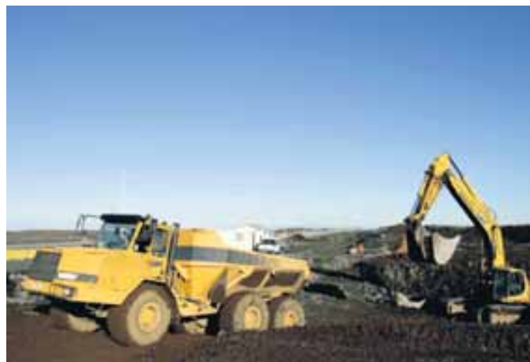
FRAMKVÆMDIR VIÐ REYKJANESBRAUT Verktakafyrirtækið Jarðvélur ráðgerir að ljúka tvöföldun 12 kílómetra vegkafla allt að ári fyrr en samið er um.
